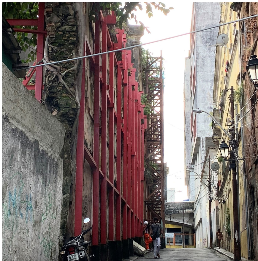
FIGURA 12 - Escoramento no Centro Histórico de Salvador após serviços de manutenção..
