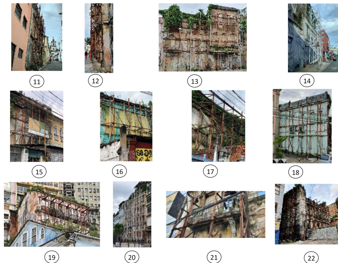
FIGURA 8 - Edificações com escoramentos aporcados na área de estudo.
